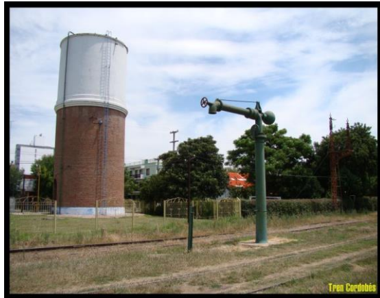
Cañería para carga de agua de locomotora
